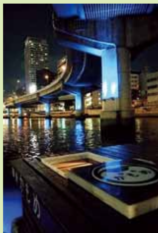
夜に見る阪神高速の橋脚は幻想的だ。
