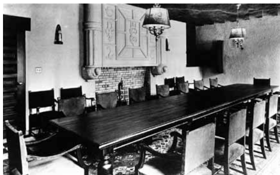
旧ダイビルの最上階にあった「大ビル倶楽部」社交室(右)と特別食堂(左)。
