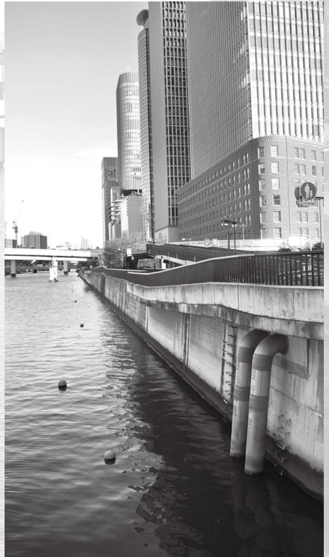
田菱橋のすぐ下に、地域冷暖房用の取水口の一つが見える。中之島では、すでに6棟が導入。3月7日に開業するホテルでも導入されている。
