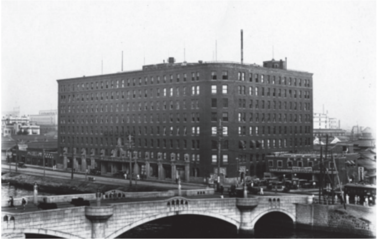
田蓑橋越しに見た竣工間もないダイビル。当時の大阪の人たちはこの眺めに圧倒された。写真提供／株式会社大林組
