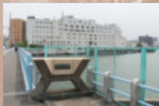
端建蔵橋は中之島の西の端にある。土佐堀川、堂島川、安治川、木津川と、多くの川が接する地点で、他にも多くの橋がかかる。
