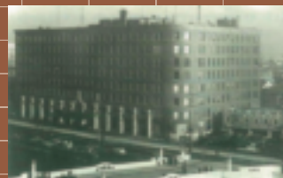
建て替え前(上)の北側部分と竣工した頃の 外観(下)。写真提供／ダイビル株式会社
