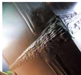
溶接痕は1本の幅が6mmほど。メガ トラス1箇所を接合するために重ね た溶接は100周以上。気が遠くなる。
