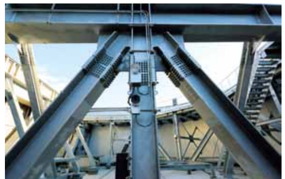
上／ラーメン構造とは柱と梁が一体化した構造のこと。短いピッチでフレームをつなぐことで、垂直方向にシャープなデザインを実現。下／屋上に隠されたハットトラスで構造性能がアップ。
