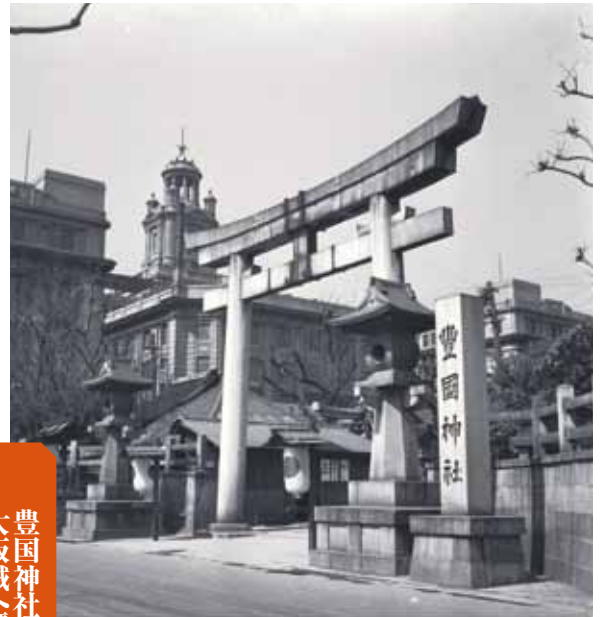
大阪市庁舎増築がささやかれ始めた頃の豊国神社。背後には、旧市庁舎を象徴する「みおつくしの鐘」。写真提供／大阪市都市工学情報センター
