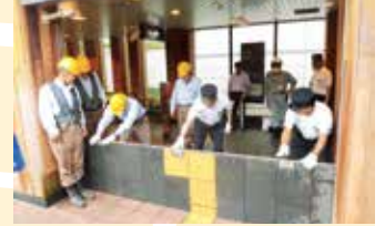
駅構内で実施する防災訓練では、負傷した乗客役を設定するなど様々な状況を想定し(上)、地下駅構内へ雨や川の水が流れ込まないようにする止水板の設置訓練も(下)。
