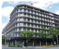
②大阪ガスビル (南館)
